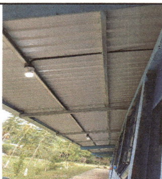
Foto 3. Módulo 3: Sustitución del sistema eléctrico en cuatro módulos de aulas. Instalación completa del nuevo sistema eléctrico en los cuatro módulos.(Exterior)
