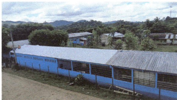
Foto1.Módulo 1.Sustitución de cubierta de lámina acanalada, por lámina troquelada. Cubierta de techo, completamente instalada en los tres módulos de aulas.
