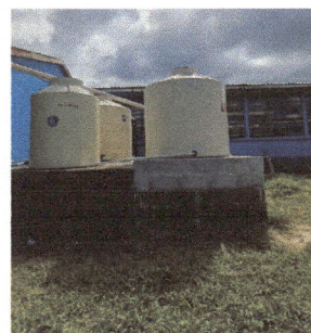
Foto 12. Módulo 8: Reparación y mantenimiento de depósito de agua. El tinaco se encuentra instalado.
