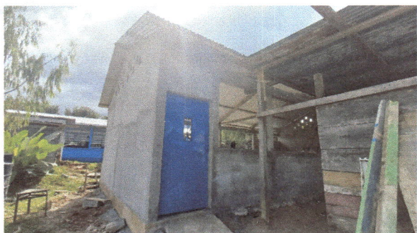
Foto 9. Módulo 6: Instalación de puertas de cocina. Puerta del lado derecho de la cocina se encuentra correctamente instalada.
