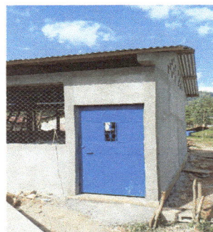
Foto 10: Módulo 6: Puerta del lado izquierdo de la cocina se encuentra instalada y en un buen estado.
