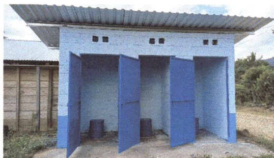
Foto 6:Módulo 4: Mantenimiento de pintura de interior y exterior del servicio sanitario finalizado.
