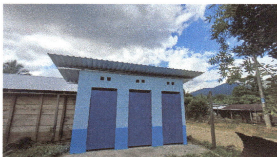
Foto 5.Módulo 4: Sustitución de cubierta de lámina, estructura de techo y puertas en el servicio sanitario. Las instalaciones fueron realizadas correctamente.
